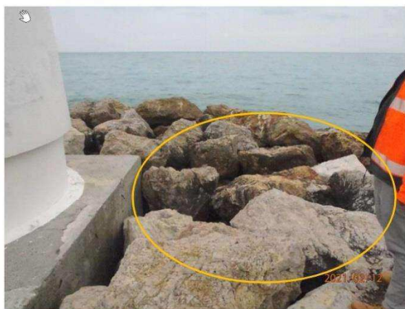
Figure 8 -Glissement des enrochements de la crête de talus en pied du musoir (source : JCECONSEIL 2021)
