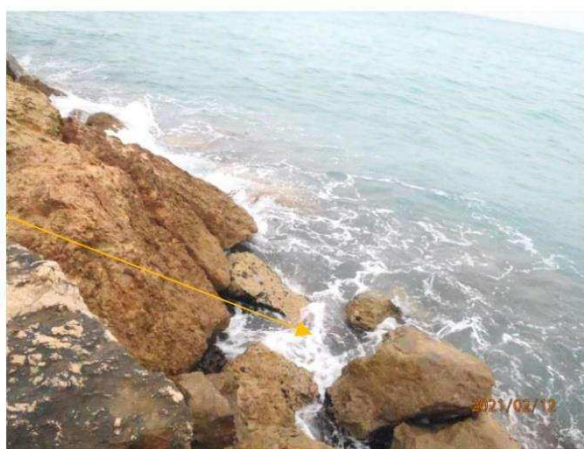
Figure 8 -Glissement des enrochements de la crête de talus en pied du musoir (source : JCECONSEIL 2021)
