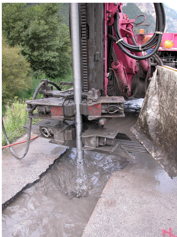
Figure 18 : Illustration du jet-grouting lamellaire
