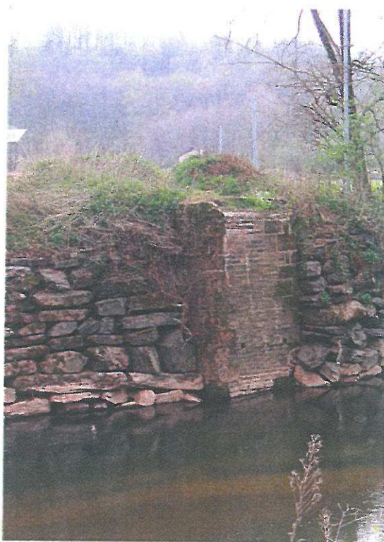
Traces de pont sur la Loyre.
