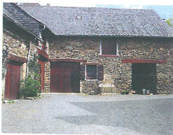
Ferme rénovée « La Chartrouille ».
