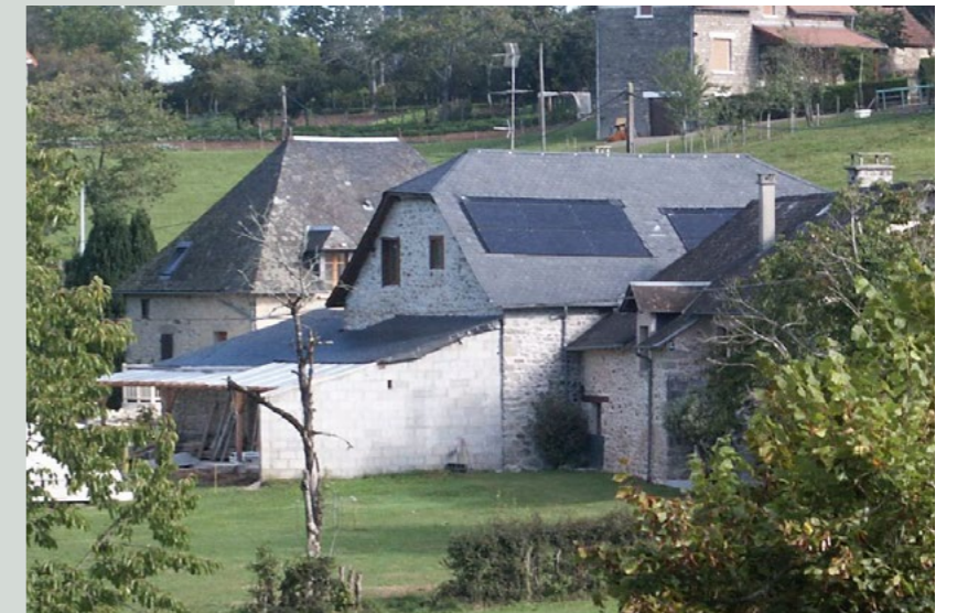
Ancienne grange-étable réhabilitée en habitation et installation de panneaux solaires
