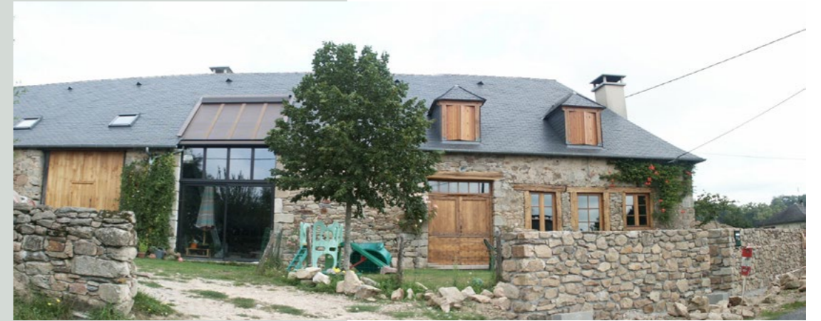
Ancien bloc à terre réhabilité avec soin
