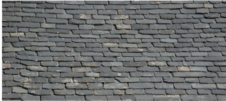
Toiture en petites ardoises rectangulaires
