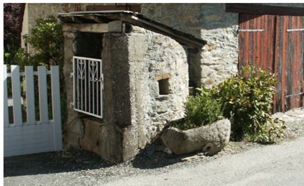
Puits et abreuvoir dans le bourg
