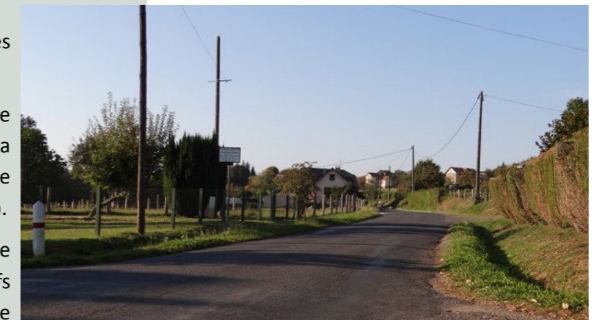
Largeur de chaussée adaptée au trafic supporté
