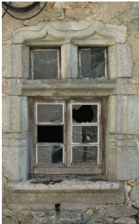
Linteaux et pierres d'angle en granite.
