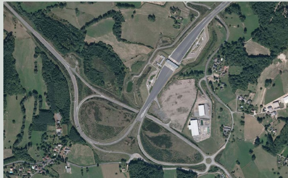
Bretelle d'accès à l'autoroute A89 de Saint-Germain les Vergnes
