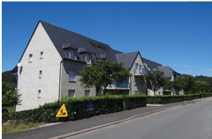
Logements collectifs à Argentat
