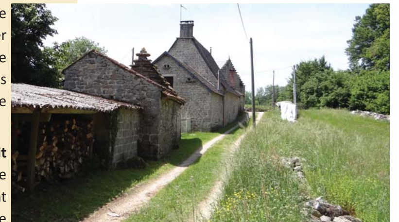
Ferme à bâtiment dissociée de l'ancien hameau de Neupont aux qualités architecturales remarquables (vue 2)
