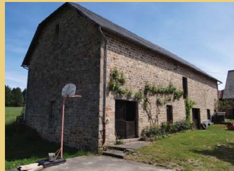
Grange ancienne (bâtiment 2) à usage de stockage pour l'EARL de la Froment vive (vue 3)
