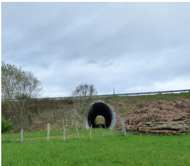
Tunnel de franchissement sous l'autoroute A20
