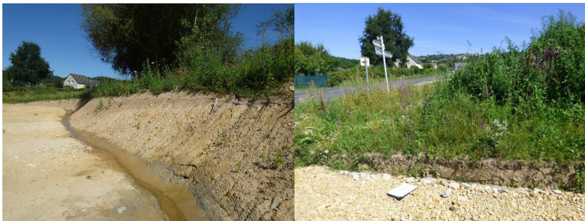
Terrassement sur la parcelle AZ 564, zone humide dans le bas et traces d'hydromorphie
