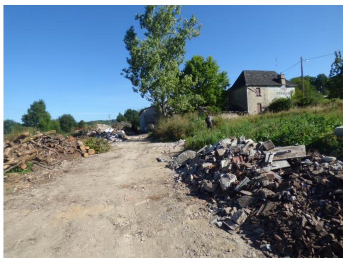
Dépôt de gravats et déchets (parcelle 546)
