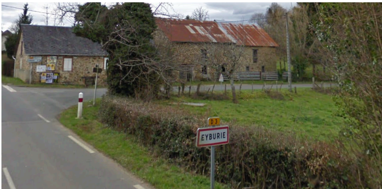
Photo du site prises depuis la rue des RD3 : entrée d'agglomération à l'intersection de la RD3 et RD26. © 2020 Google
