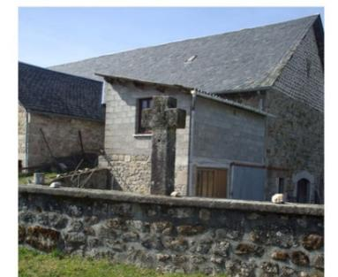
Extension en parpaings et ciment dans le prolongement d'un bâti ancien usant de matériaux traditionnels.
