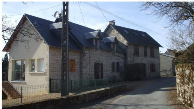
Corps de ferme à éléments séparés : logis en deux eaux rehaussé d'un étage, grange adossée en pignon, extension contemporaine en pierre et chaux sur la façade principale.
