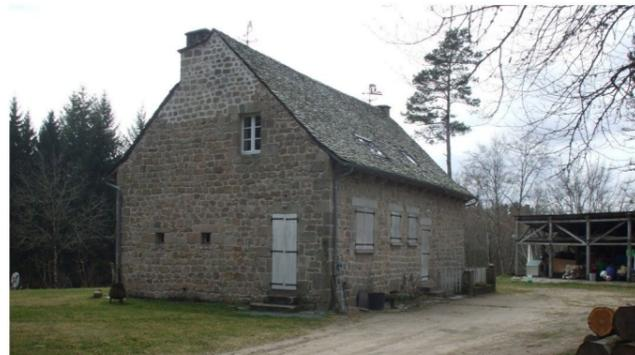
Bloc-à-terre réhabilité avec des codes architecturaux traditionnels (toiture en lauzes) et modernes (ouverture de fenêtres en façade Nord, châssis de toit et linteaux béton) à *la Jugie*
