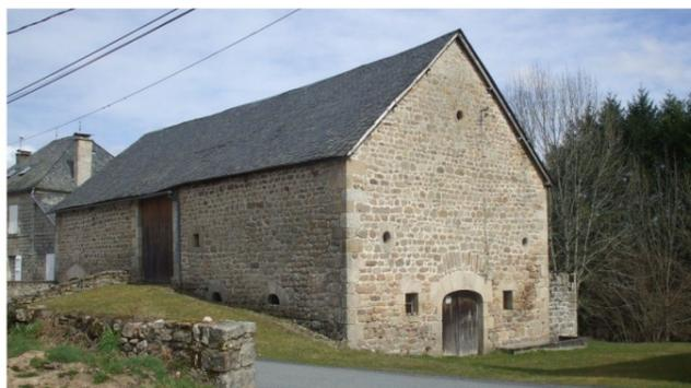
Grange-étable auvergnate indépendante à *la Jugie* : porte charretière centrale à l'étage accessible par une "montade" en mur gouttereau, étable à un niveau en dessous.
