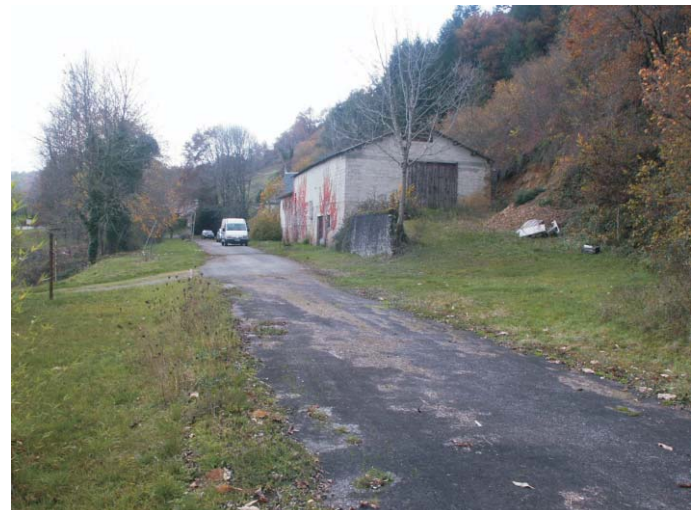
Bâtiment en parpaing non enduit.
