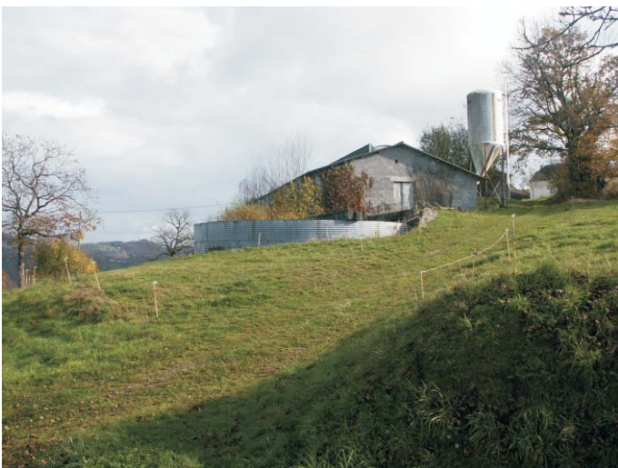
Bâtiment agricole non enduit, silo et fosse à lisier peu esthétiques.
