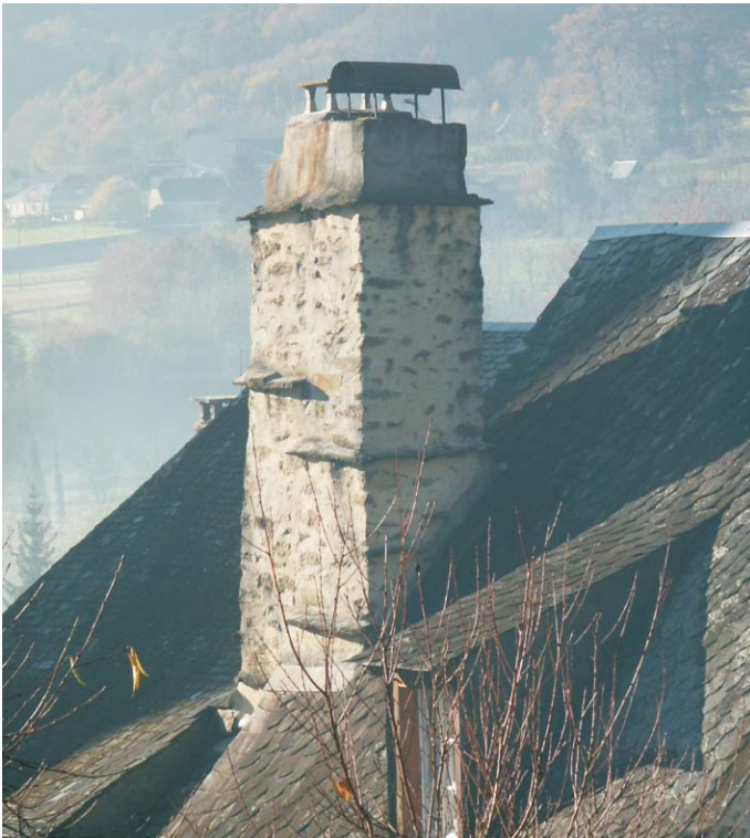
Souche de cheminée monumentale.
