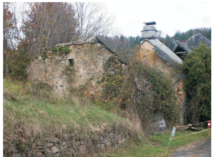
Destruction du patrimoine bâti.
