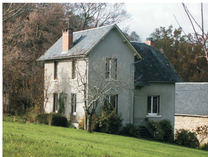
Maison du milieu du XX ème , fortement marquée par l'usage du ciment.
