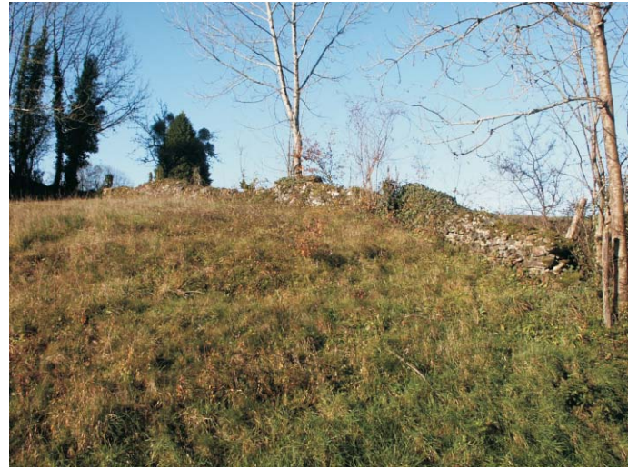
Muret de pierres sèches à Plos .
