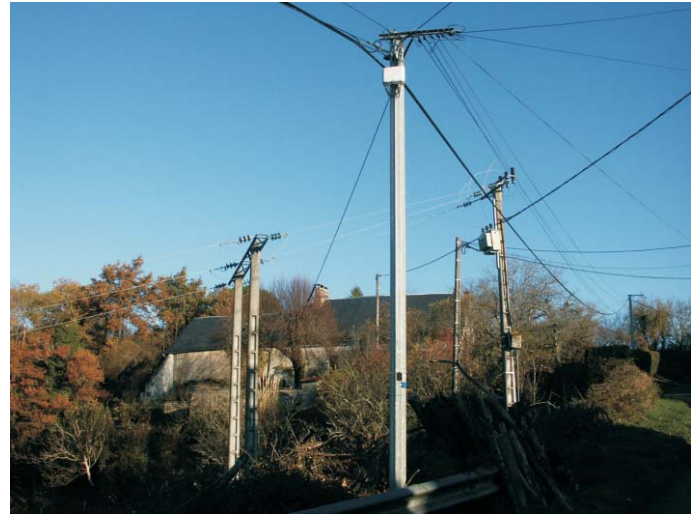
Multiplication des réseaux aériens.
