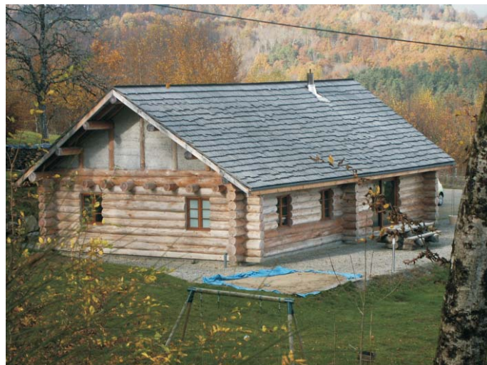
Maison en fuste. Encore peu développée en Corrèze et de connotation montagnarde, son intégration paysagère demeure difficile.
