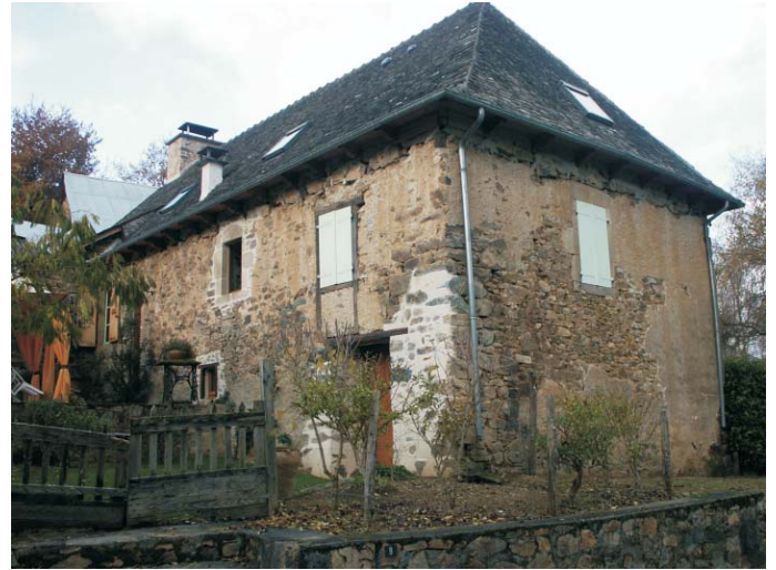
Logis de ferme à cave haute.
