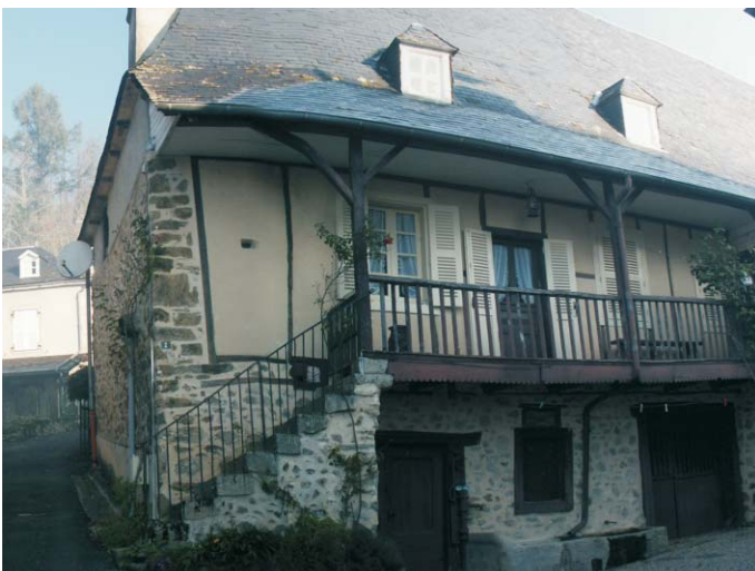
Maison à "balet" typique des environs de Beaulieu et Argentat.
