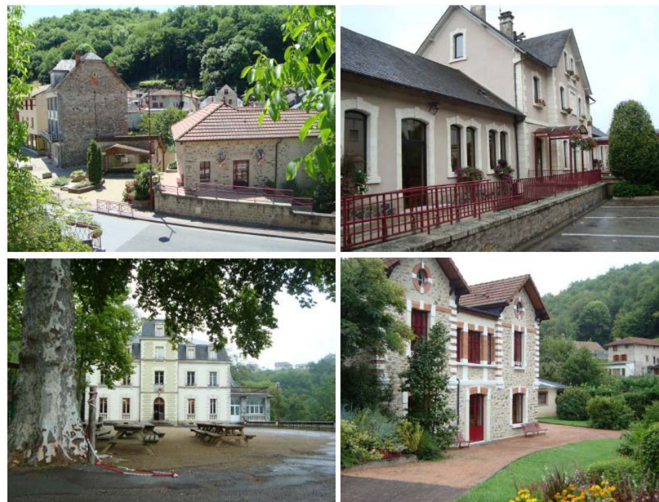
Vues des équipements de la commune et du centre aéré du Chambon
