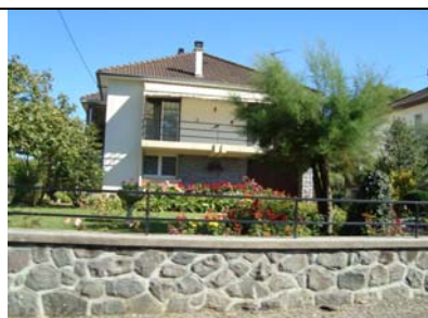
Autorisé : muret maçonné ou enduit, avec grille ajourée
