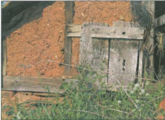
Mur en torchis à La Chambre
