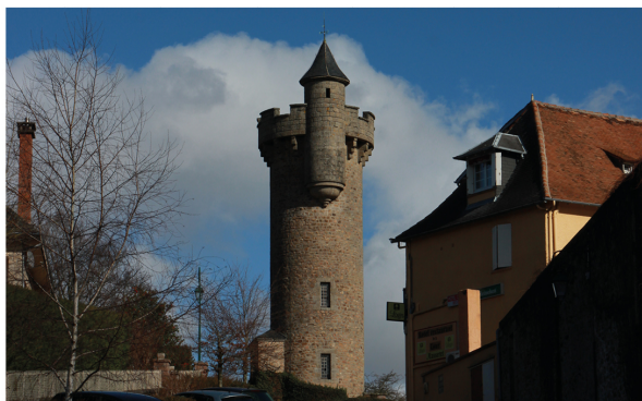
Château d'eau, commune de Masseret
