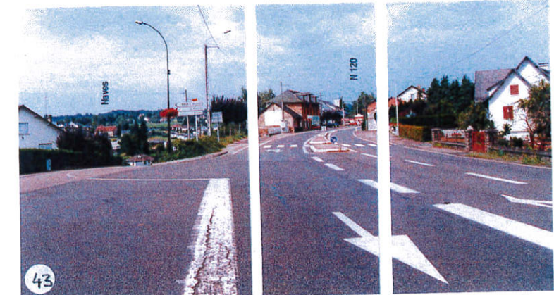
Les abords de la N120 présentent un caractère plus urbain que l'entrée de Naves
