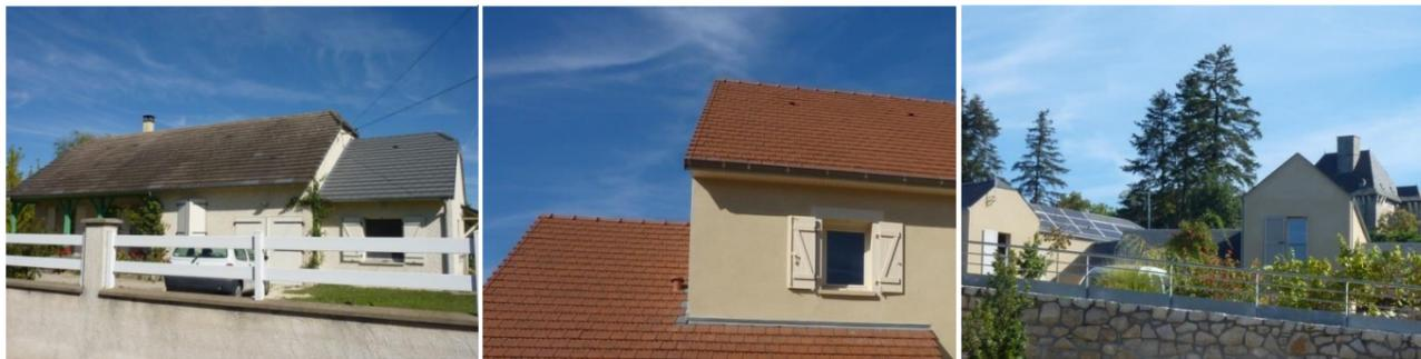
Diversité des matériaux de recouvrement avec de ◀ à ▶ : Extension dont le matériau de recouvrement de la toiture imite l'ardoise ; utilisation de tuiles plates ; Intégration du photovoltaïque.
