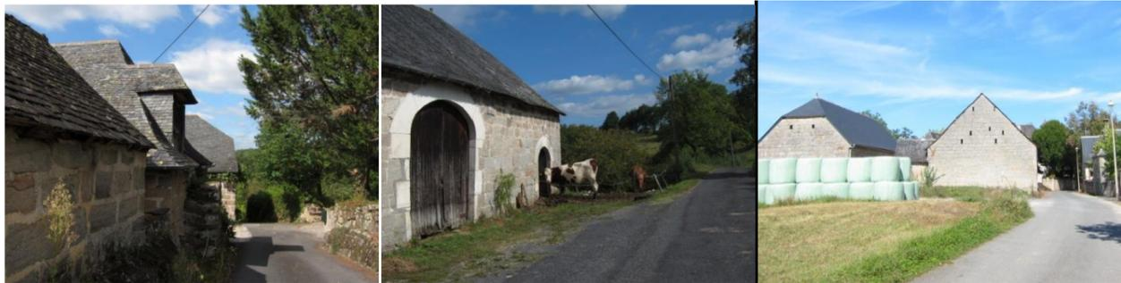
Lucarne engagée dans la maçonnerie servant de ventilation. Porte charretière facilitant le passage du matériel agricole. Fenestrous répartis de façon symétrique sur le mur-pignon et permettant de répartir la ventilation du comble sans amener l'eau de pluie.
