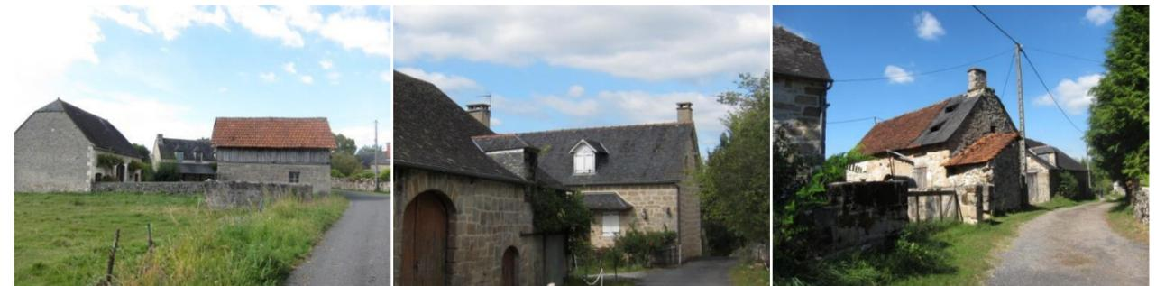
Toiture à deux pans avec croupe. Utilisation de la tuile plate, Tuile canal soulignant les lignes de faîtage des toitures mais également des lucarnes.
