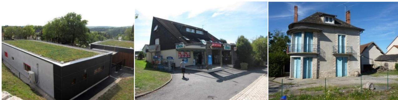
Toiture terrasse végétalisée de l'école, toiture du multiservice recouvrant une partie de la façade ; toiture à deux pans avec simple courbure : la toiture à deux pans qui au lieu de se rejoindre à un angle, se rejoint dans une courbe
