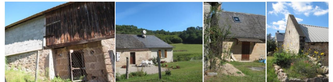
Dépréciation du bâti traditionnel par la dissonance créée de par le choix des matériaux de constructions utilisées : Exemple d'intervention sur le bâti traditionnel (extension et ou réhabilitation) compromettant la qualité architecturale : Les Landes, Lamouroux, pose d'une fenêtre de toit, utilisation de bardage métallique pour le recouvrement des toitures.
