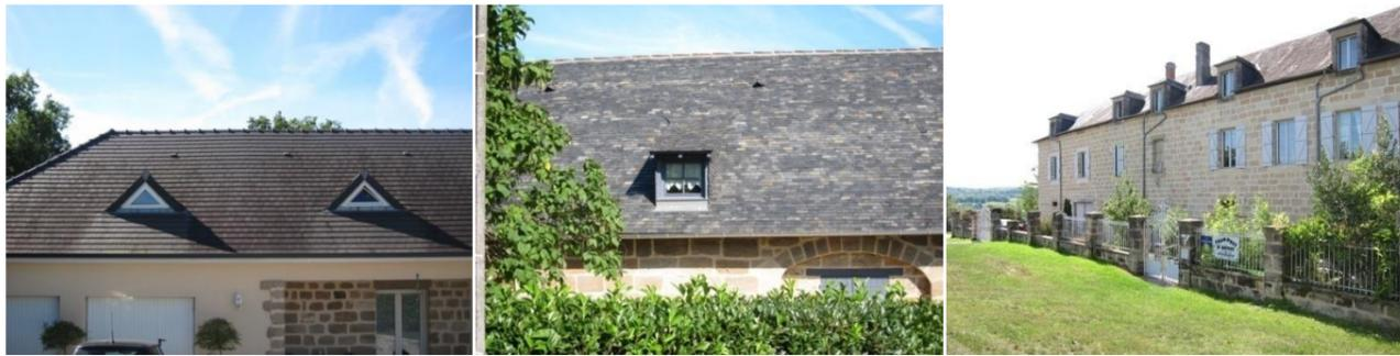
Diversité de traitement des ouvertures sur combles avec de ◀ à ▶ : Outeau triangulaire caractérisant une petite lucarne à deux versants ; Lucarne rampante dite en chien couché, Lucarne à croupe dite capucine
