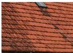
Toiture tuiles terre cuite
