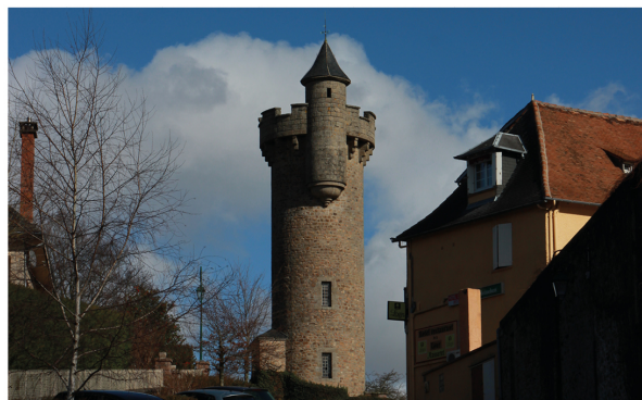
Château d'eau, commune de Masseret
