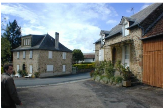
L'échelle du bourg oblige à la sobriété des espaces extérieurs collectifs, économiquement et symboliquement.
