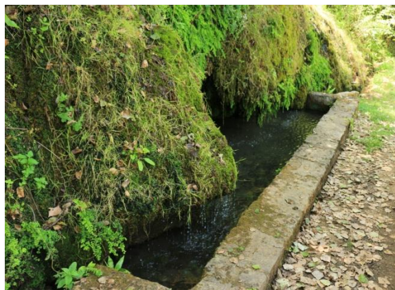
Réservoir de faible taille inclut dans la paroi rocheuse récoltant les eaux de ruissellement en partie filtrée par un tapis de mousses et de fougères (situé sur la commune de Saint-Robert )
