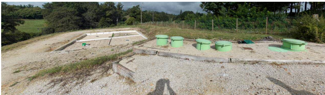
PHOTO 6 : STATION DE TRAITEMENT DES EAUX USEES DU BOURG
