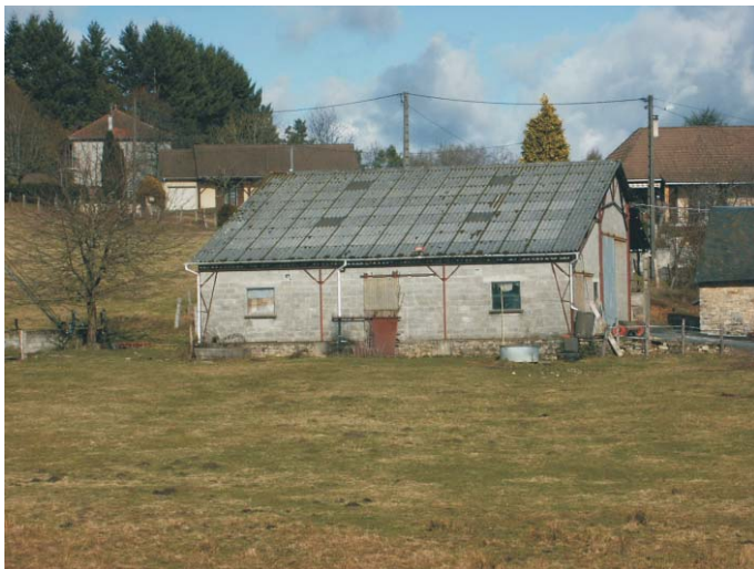
Bâtiment en parpaing non enduit.
