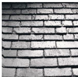
L'ardoise épaisse de Cornèze se distingue par son épaisseur (sup. à 4/5mm) ainsi que par son irrégularité : les joints sont dits « brouillés ». Elle se pose au clou sur un support en volige. Les plus grandes ardoises sont posées en partie basse du versant, tandis que les plus courtes sont réservées au faitage. Cette technique s'appelle la « pose à pureaux décroissants », le pureau étant la partie non recouverte, donc visible, de l'ardoise.
