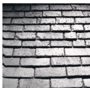
L'ardoise épaisse de Corrèze se distingue par son épaisseur (sup. à 4/5mm) ainsi que par son irrégularité : les joints sont dits « brouillés ». Elle se pose au clou sur un support en volige. Les plus grandes ardoises sont posées en partie basse du versant, tandis que les plus courtes sont réservées au faîtage. Cette technique s'appelle la « pose à pureaux décroissants », le pureau étant la partie non recouverte, donc visible, de l'ardoise.
