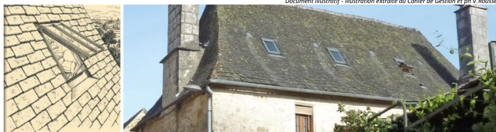
Les châssis de toit devront s'inspirer des modèles traditionnels anciens, être de dimensions limitées et encastré dans le plan de la couverture.
