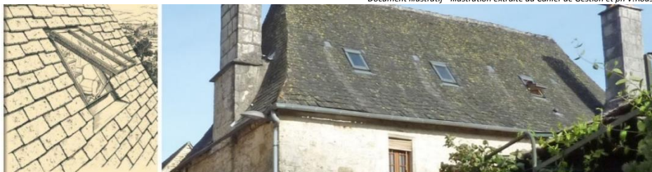
Les châssis de toit devront s'inspirer des modèles traditionnels anciens, être de dimensions limitées et encastré dans le plan de la couverture.
