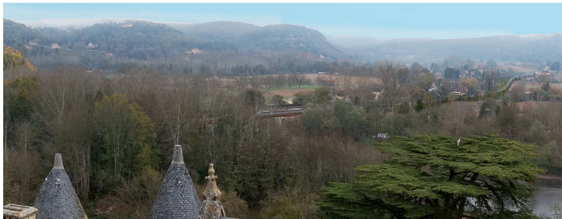
Photo 29 : Photomontage du projet – vue depuis le château de Fayrac vers le Pont de Fayrac (setec TPI/Spielmann/Craquelin, 2016)
