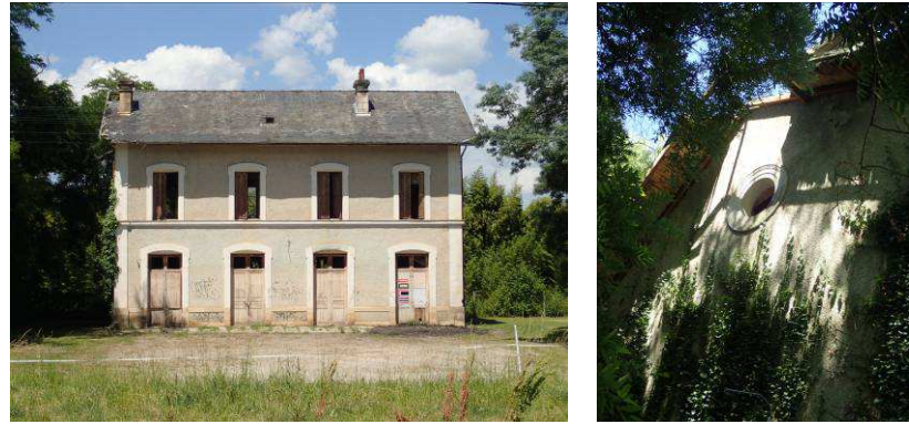
Ancienne gare de Castelnau-la-Chapelle avec l'accès aux combles (à gauche et au centre) (BKM, 2016)
