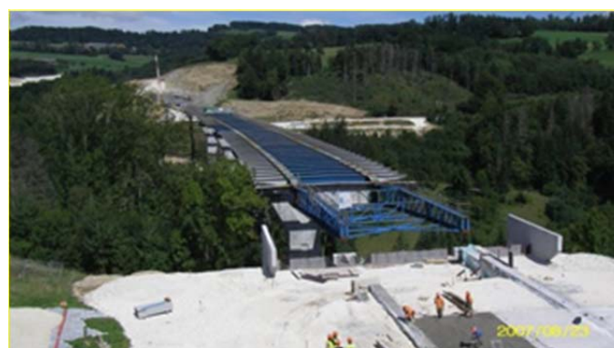
Photo 2 : Lançage d'un Viaduc des Usse A41 Nord (Setec)
