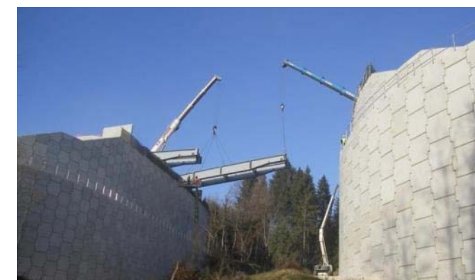
Photo 1 : Exemple de pose à grue d'un ouvrage d'art : PI 161 La Ravoire - A41 Nord (Setec)
