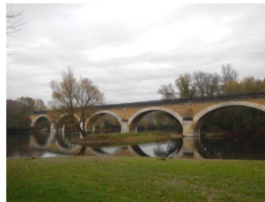
Photo 14 : Vue de la connexion à l'annexehydraulique avec le lit de la Dordogne (rive gauche) (source : MEP19, novembre 2016)
