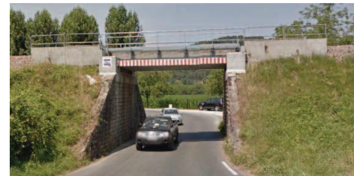
Figure 9 : Tunnel pour le passage de la RD703 (La Grange de Vergne)
