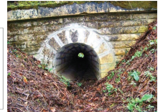
Figure 45 : Ouvrage de rétablissement pluvial SNCF de La Grange de Vergne
