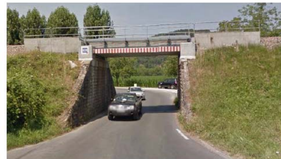
Figure 6 : Passage inférieur de la RD703 (La Grange de Vergne)
