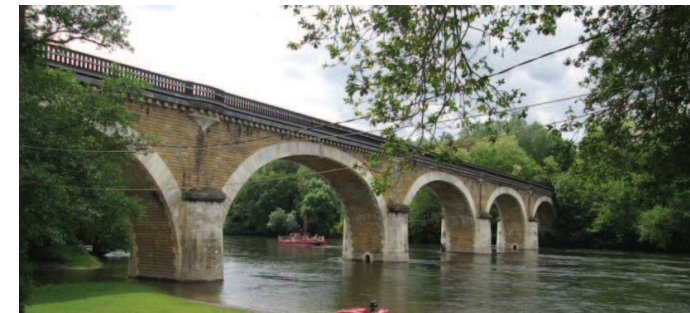
Figure 7 : Pont de Fayrac
