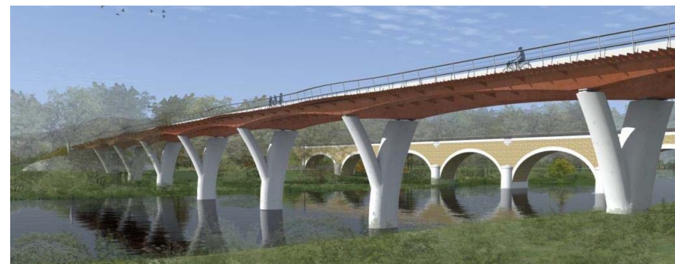
Figures 8 et 9 : Le pont sur la Dordogne, dit « pont du Pech »
