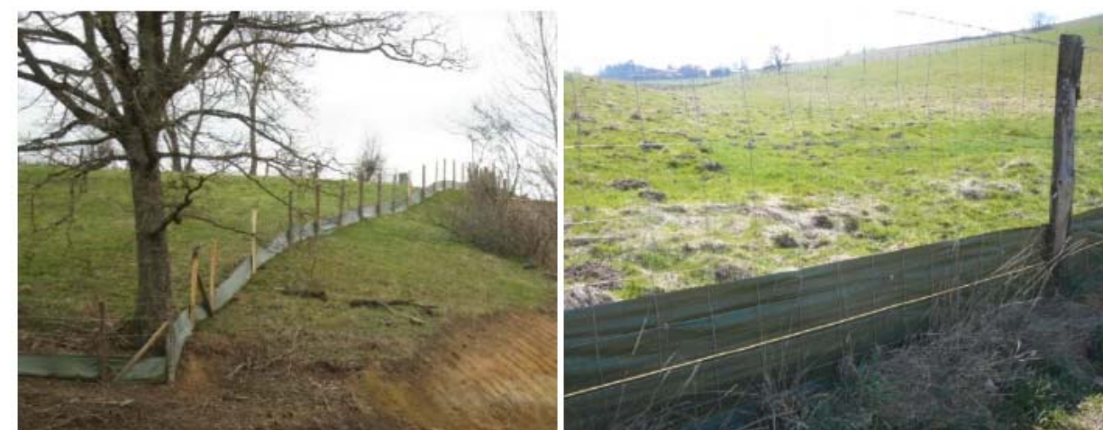
Photo 20 : Mise en place de « bâches amphibiens » en phase travaux (Source : A89, SETEC)
