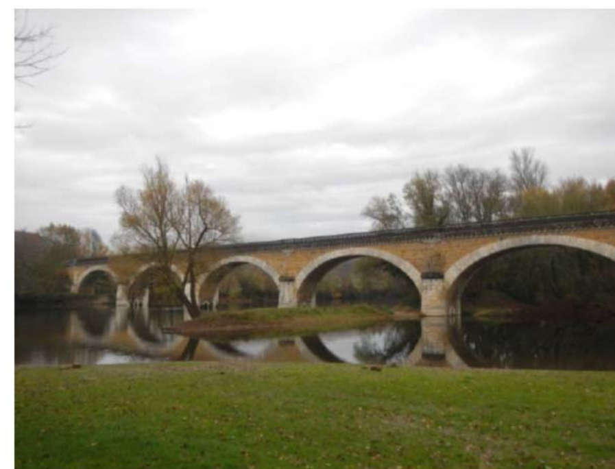
Photo 12 : Vue de la connection à l'annexhydraulique avec le lit de la Dordogne (rive gauche) (source : MEP19, novembre 2016)
