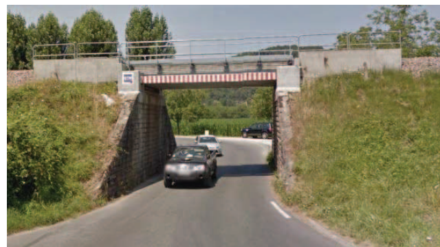
Figure 44 : Passage inférieur de la RD703 (La Grange de Vergne)
