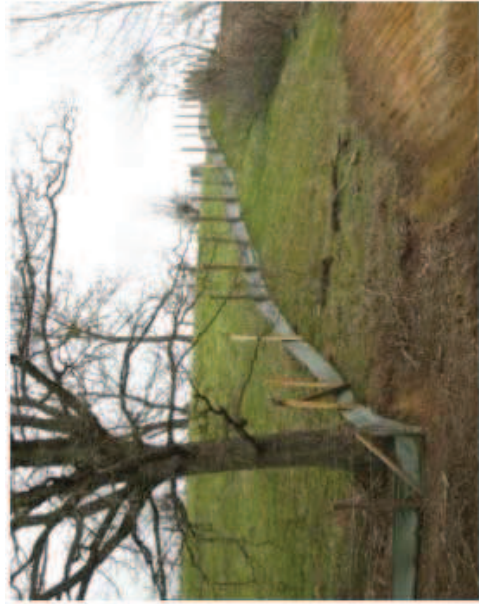
Photo 34 : Mise en place de « bâches amphibies » en phase travaux (Source : A89, SETEC)
