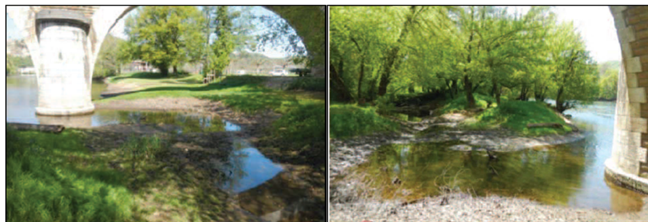
Figure 3: Vue depuis l'amont (image du haut – Biotec avril 2007) et depuis l'aval (images du bas - MEP19 avril 2017).
