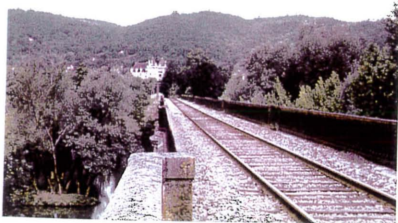
① Voie SNCF sur l'ouvrage sur la Dordogne.
