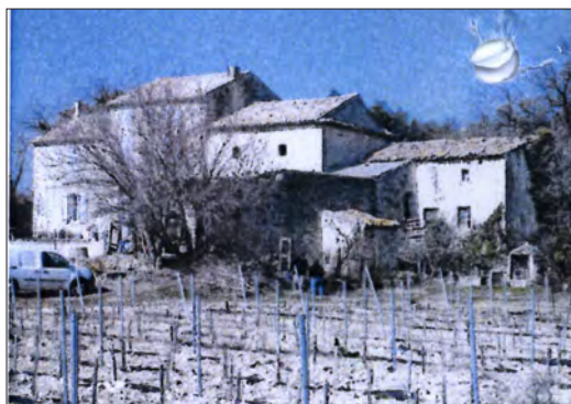
Vue d'ensemble depuis Sud Est
