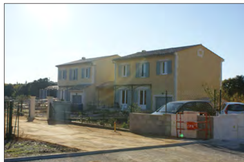
Exemples de bâtiments récents qui reprennent de manière intéressante les gabarits de l'urbanisation ancienne de faubourg.
