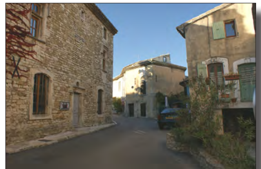
Structure du bâti du centre historique.
