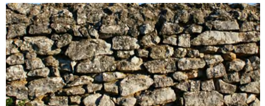
Une structure de maçonnerie ancienne.
