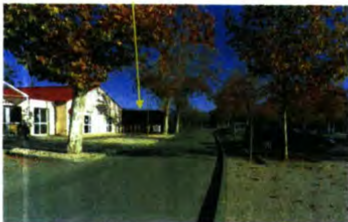
1 : Vue depuis l'Ouest sur la RD128 ; Le site est invisible derrière la haie de la salle des fêtes.
