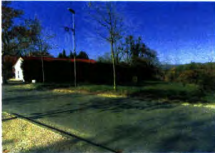
5 : Vue proche du site depuis le stationnement de l'autre côté de la RD128.
