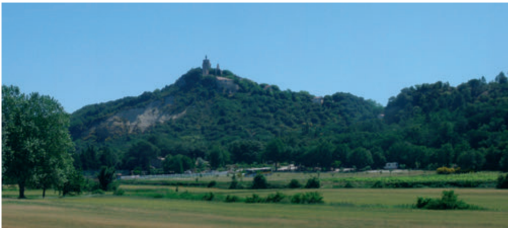
Clansayès sur son éperon rocheux
