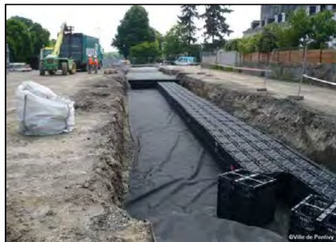
Mise en place d'une structure réservoir
