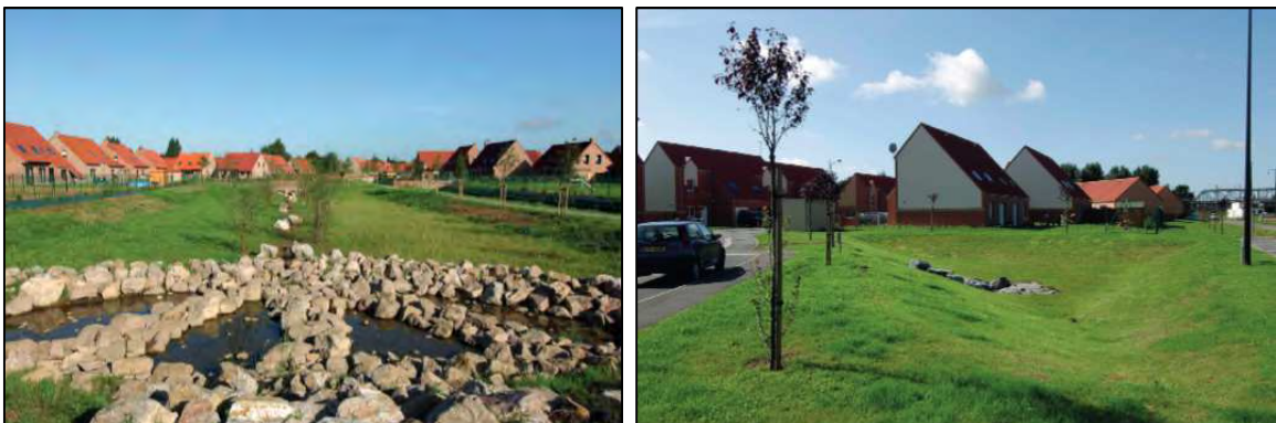
Bassin sec – intégration paysagère
