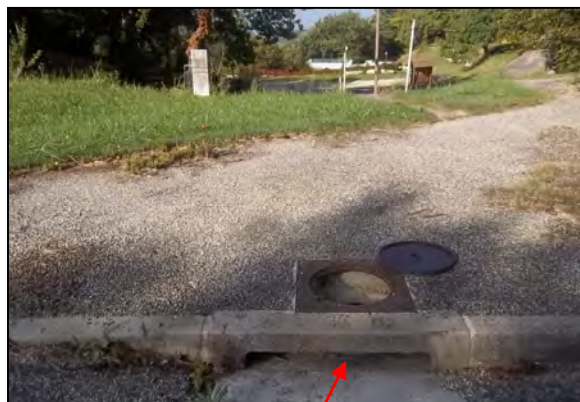
Arrivée des eaux de ruissellement
