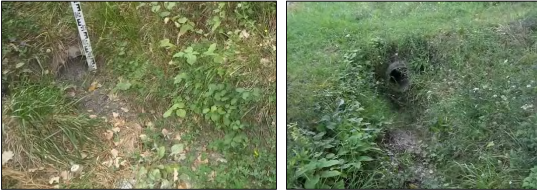
Figure 11 : planche photographique - busage en béton ayant drainé des gravillons
