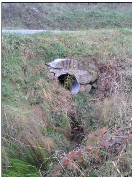
Figure 6 : buse bétonnée évacuant les eaux pluviales
