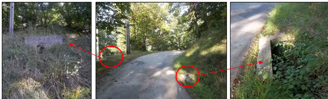
Figure 10 : planche photographique de la buse chemin du Grand Serre
