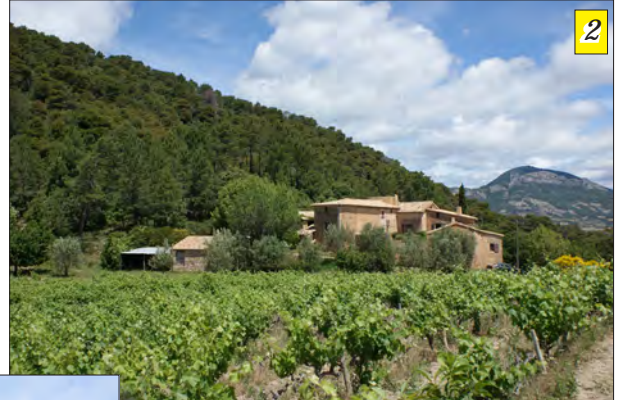
Un corps de ferme massif, comme il en existe peu dans la commune, témoin de l'architecture rurale locale.
