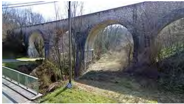
16 – Le viaduc du tram
