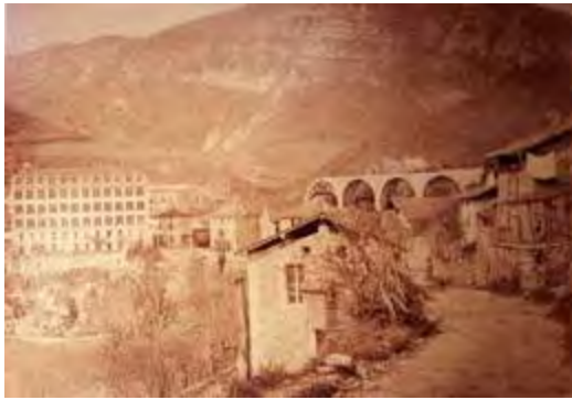
Construction de l'aqueduc
