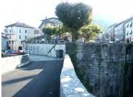
Ancien pont médiéval
