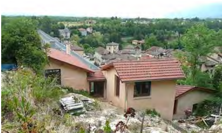
projet de rénovation-extension-surélévation en cours, rue du Mazel, au sud de l'aqueduc.
