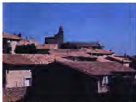
Paysage de toitures – vision d'un ensemble compact.
