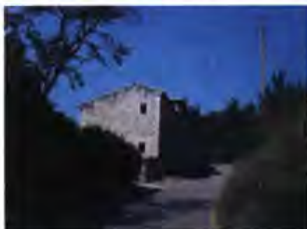
Perception duale entre une façade aveugle au nord et une façade largement ouverte au sud.
