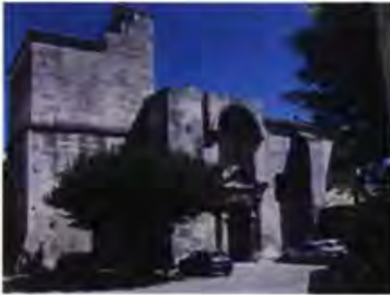
Place de l'Eglise – Nombreux stationnements dénaturant les éléments patrimoniaux en présence.
