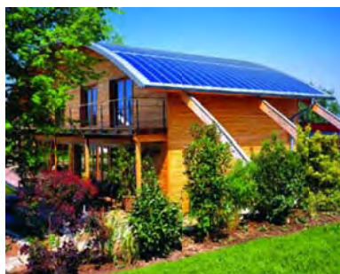
Exemples d'intégration de panneaux solaire en toiture
