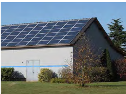
Exemples d'intégration de panneaux solaire en toiture
