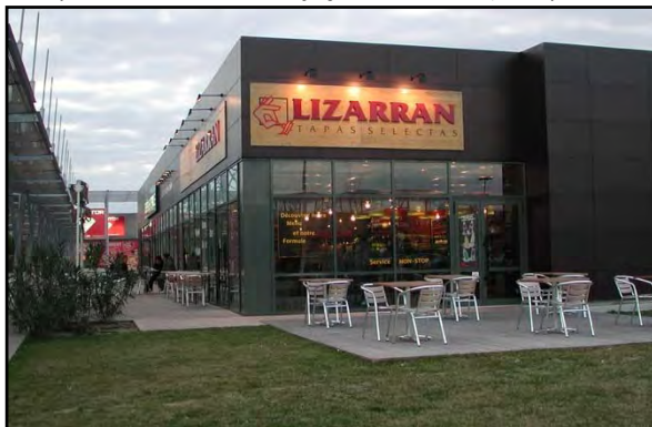
Exemple de revêtement de façade (enseignes sur la façade, de dimensions limitées, éclairées par spots discrets, bâtiment « partagé » par plusieurs établissements)
