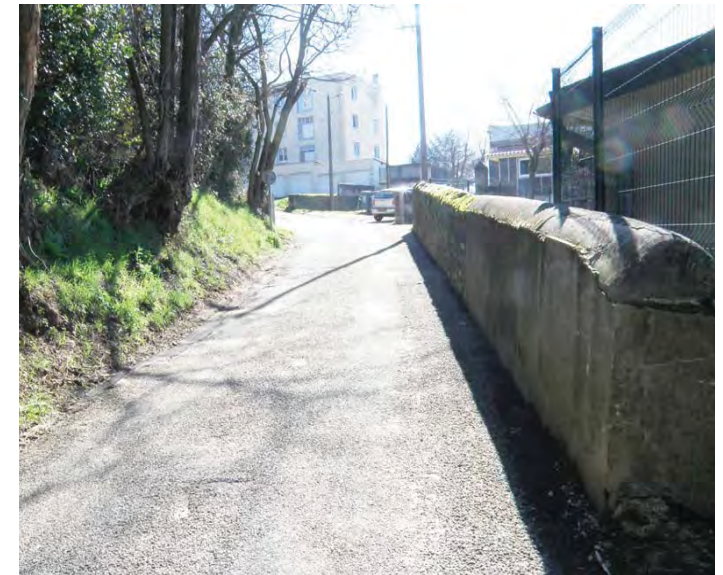
Vue 3 - Le passage le plus étroit, à proximité des préfabriqués.
