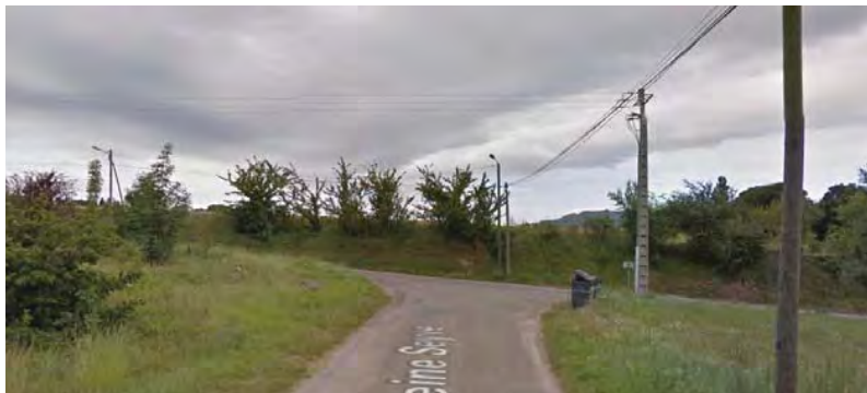
Depuis la V.C. 16 (chemin de la Pleine Seyne), les arbustes et l'emplacement des containers réduisent la visibilité. L'emprise réduite de la voie ne facilite pas le braquage des véhicules ni leur croisement.
