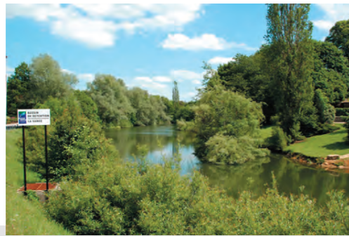
Bassin de rétention à Villers lès Nancy (54)
