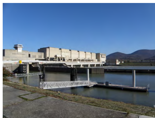
Aménagement hydraulique: canal d'amenée
