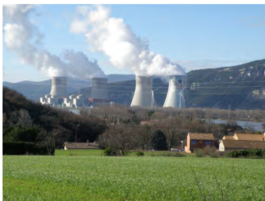
Centrale nucléaire de Cruas
