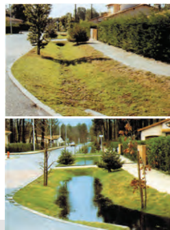
Fossés de récupération des eaux pluviales à Bois-Guillaume (76)
