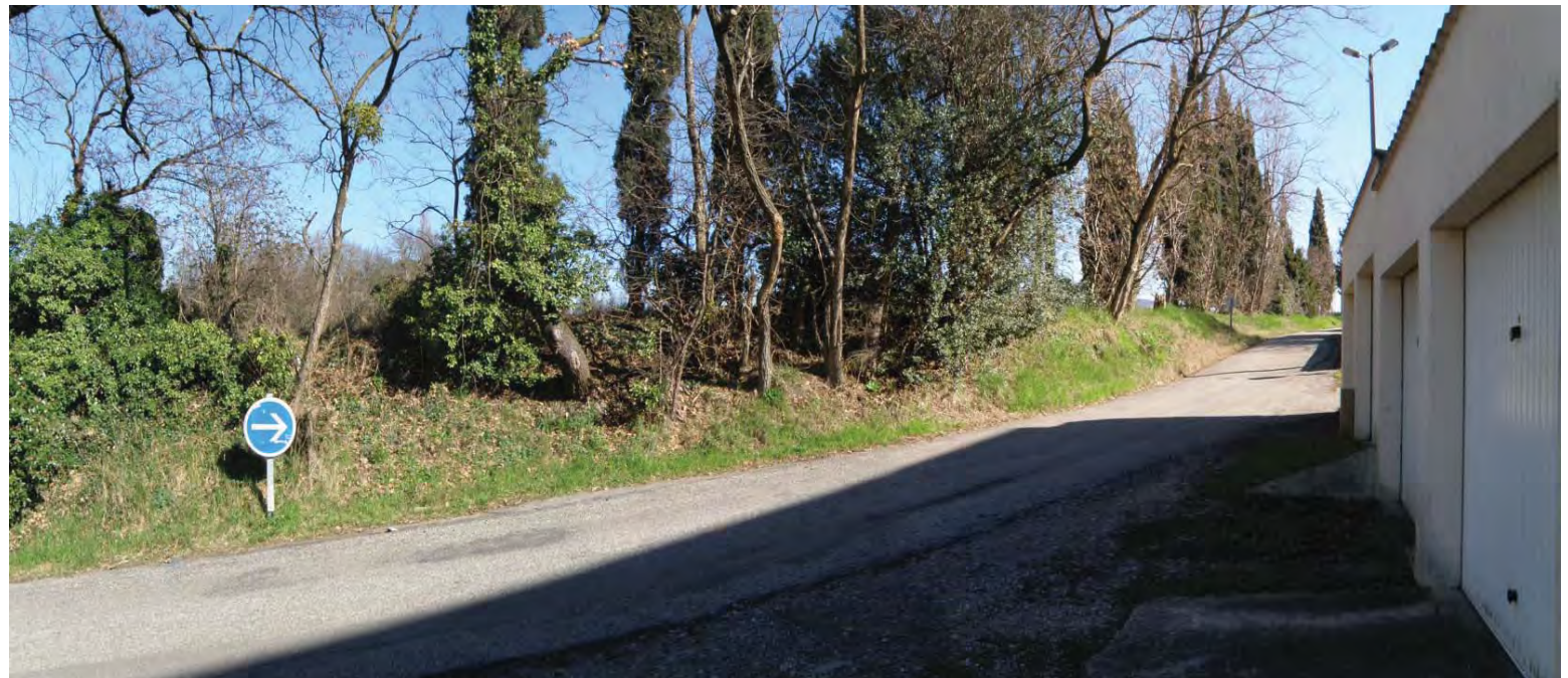
Vue 5 - L'espace se resserre à nouveau, cependant le talus diminuant de hauteur et la végétation devenant moins dense, permettrait un éventuel élargissement.
