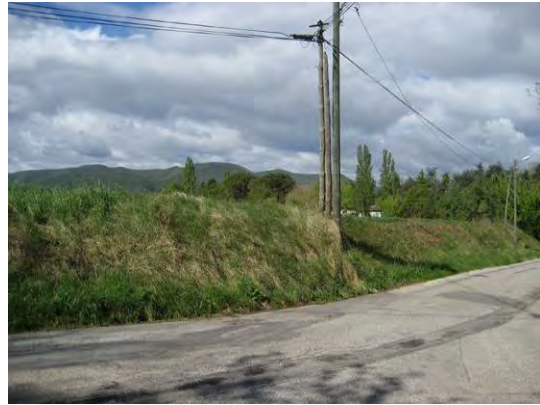
Le talus vu du chemin des Comtes
