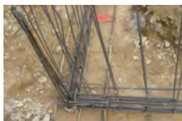
Nœud de chaînage - Continuité mécanique
