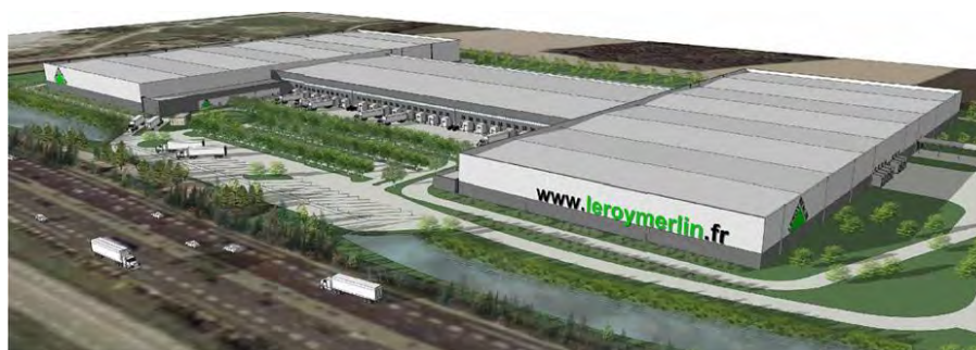
Centre logistique Leroy Merlin
