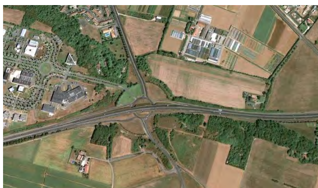
L'échangeur à la hauteur de la ferme Monteil a engendré une coupure dans le boisement qui vient de l'est et qui ceinture le plateau de Lautagne, Source : AVAP
