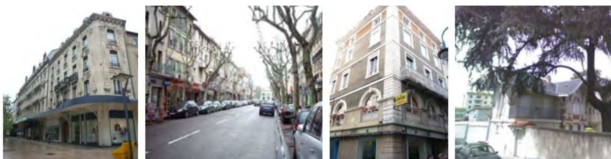
L'architecture du XIXe siècle, source : AVAP
