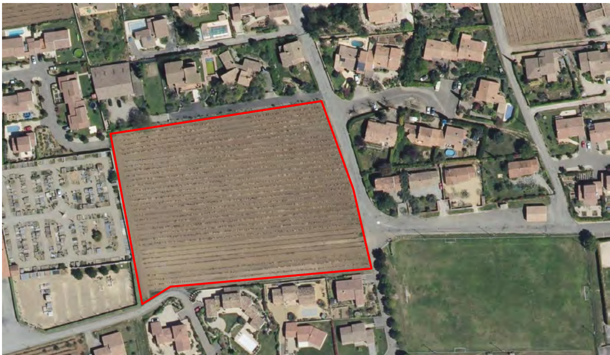
Vue aérienne du site de La Paran
