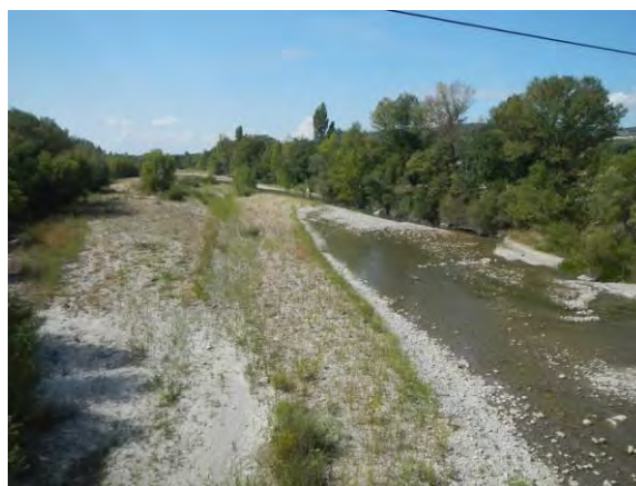
L'Eygues depuis le pont sur la RD4 vers l'aval
