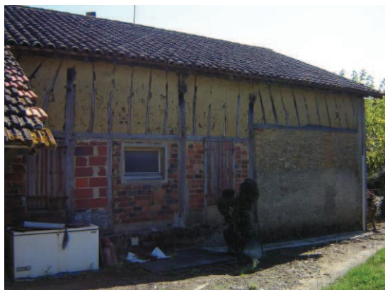
Une grange, mélange de matériaux
