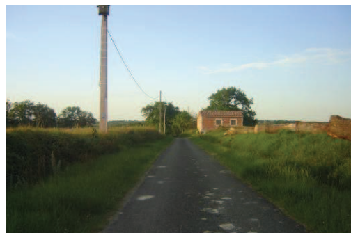
Un petit pavillon en construction au Nouet
