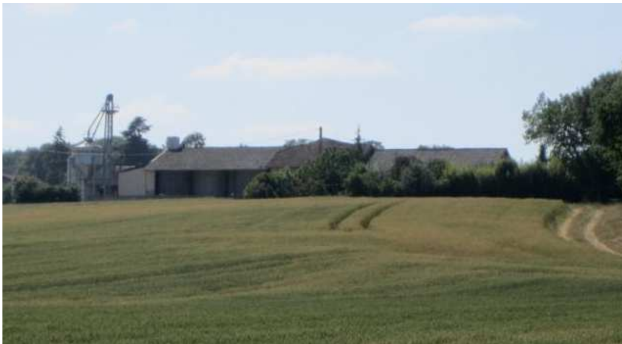
Photo 15: Bâtiments agricoles de stockage
