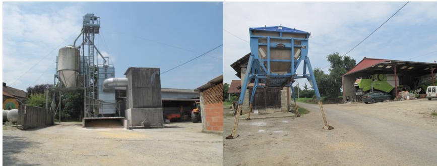
Installation récente à vocation agricole servant au stockage de la production à Fauron et à Callat
