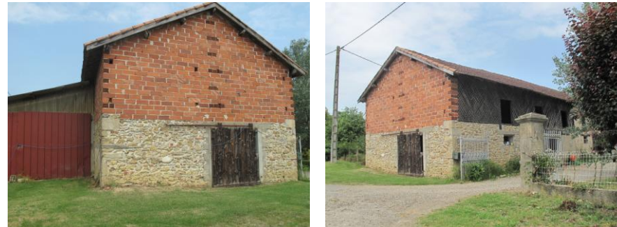
Diversité des matériaux de constructions employés pour la réhabilitation et l'extension dénaturant la qualité du bâti originel, secteur Lapy ci-dessus.
