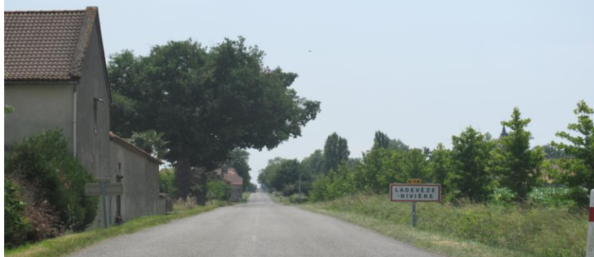
Entrée Nord dans Ladevèze-Rivière en provenance de Plaisance
