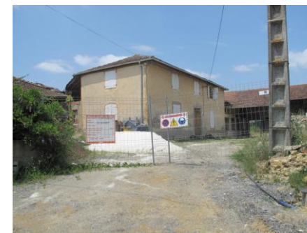
Chantier en cours, Pierrot/Rousseau
