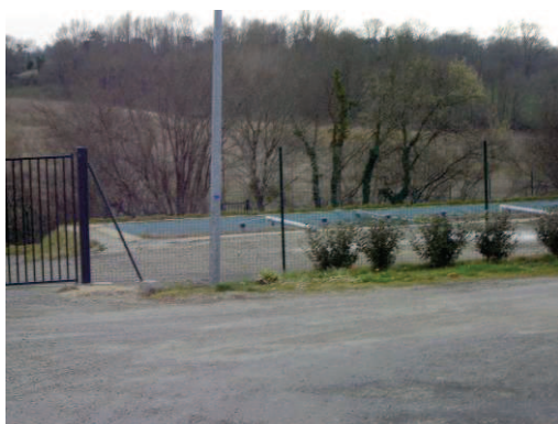
Station d'épuration au pied du bourg
