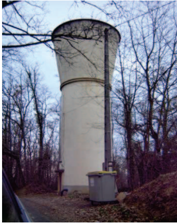
Le château d'eau à Sarraille
