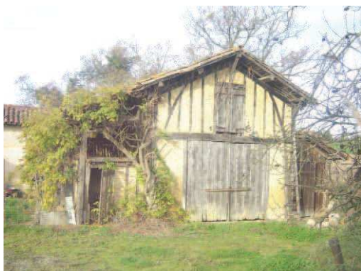
Maison à colombage et torchis
