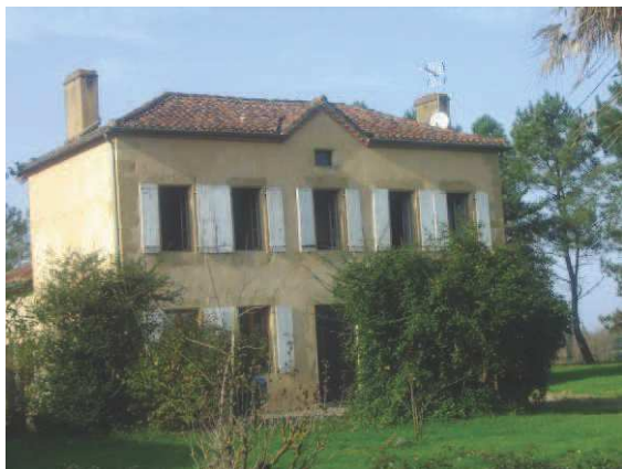
Maison de maitre à Violles
