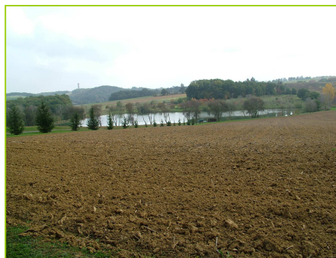
Retenue Collinaire – Lieudit « Sombres » Source : TADD
