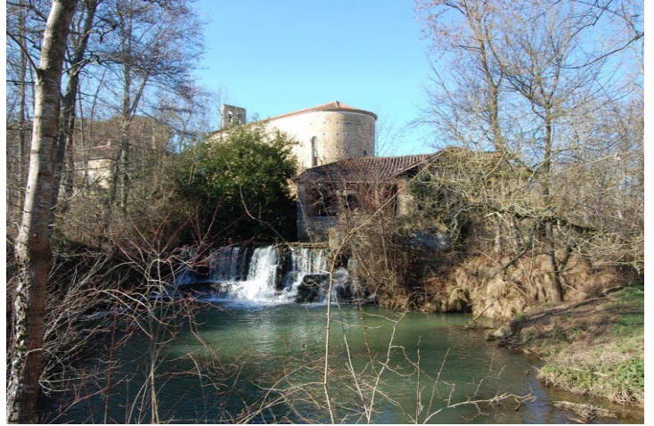
Barrage sur l'Arrats
