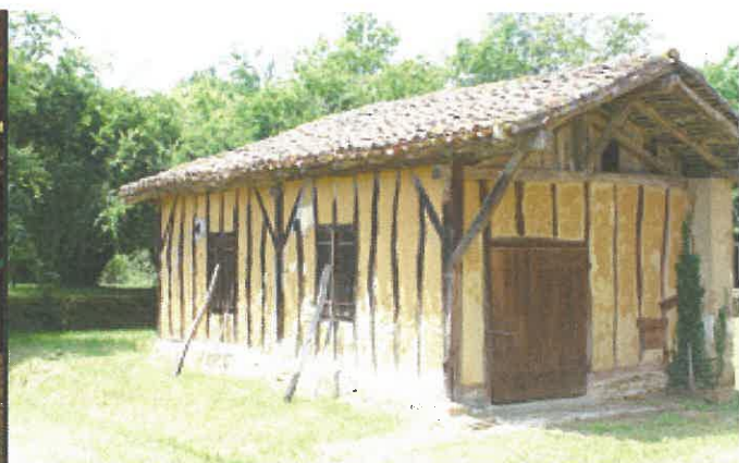
Maison à pans de bois
